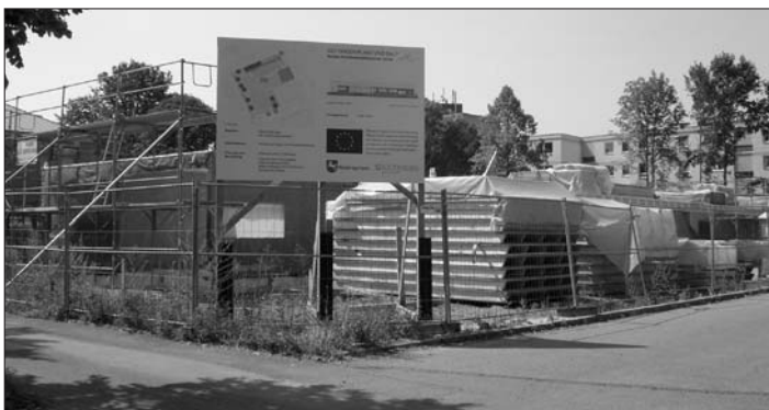
Die Baustelle des neuen Nachbarschaftszentrums.
